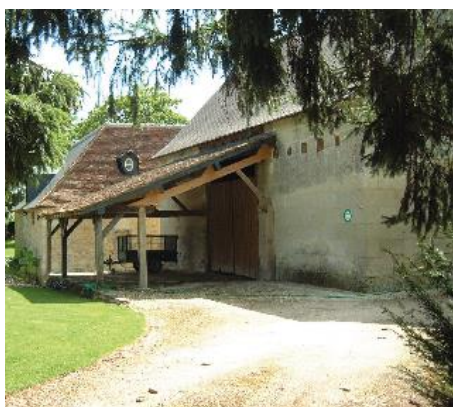
Le Moulin Basset, bel ensemble en pierre de taille du XVIII et XIXème siècle avec son toit à longs pans
